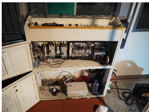
図17 配電盤とモニタリング装置
